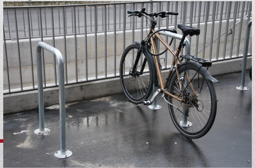
Veloklammern nicht windsicher Mögliche bessere Velobügel
